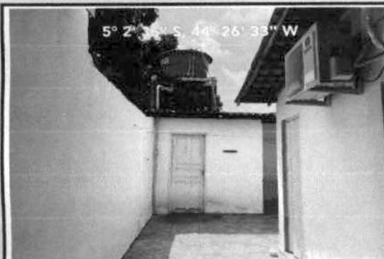
FOTO 11 - ÁREA EXTERNA CAIXA D'ÁGUA ELEVADA Fortlev 500 L
